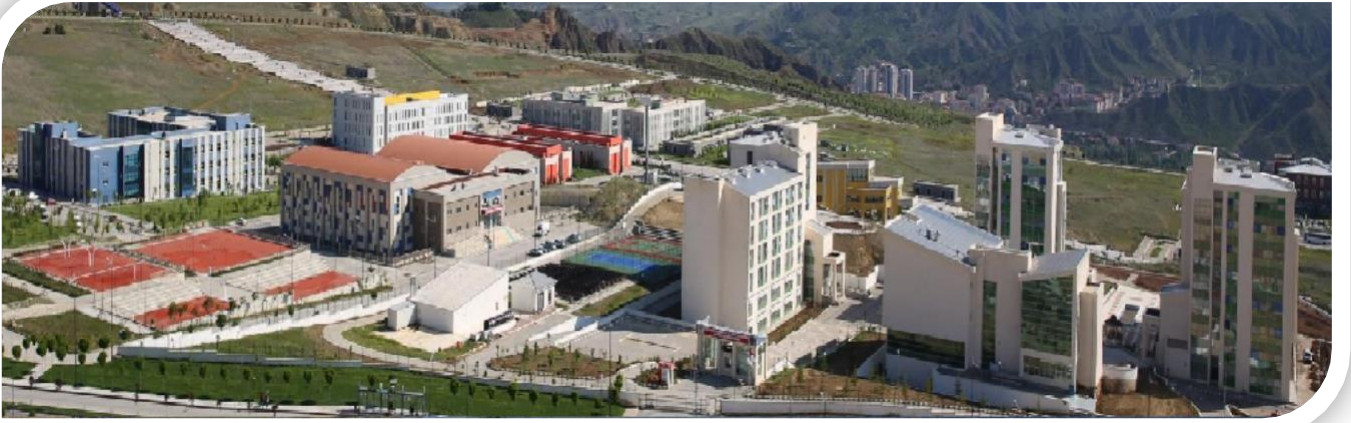
Şekil 5. Uluyazı Yerleşkesinden Bir Kesit.
